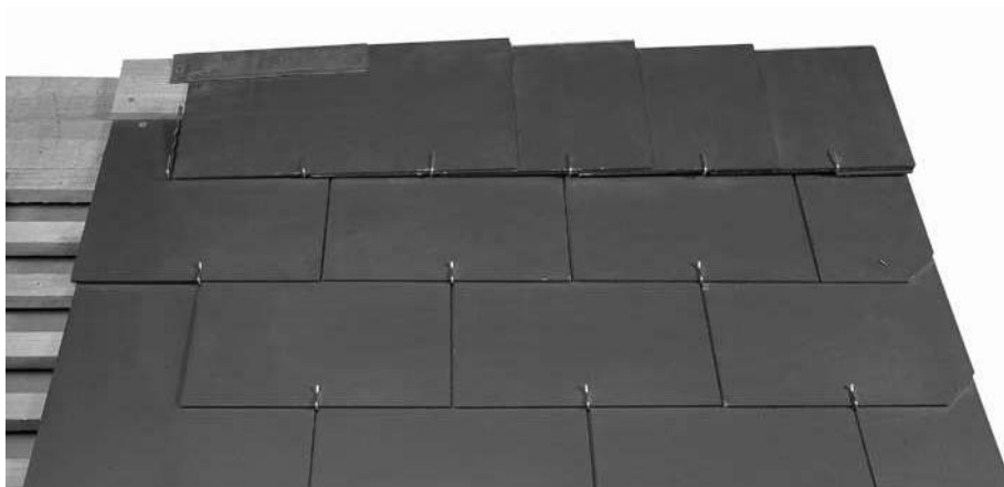
Foto 3: Nok in Strackort-afwerking
