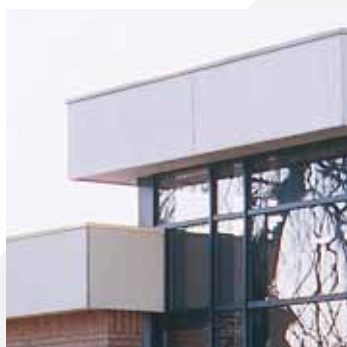
Afwerking dakranden
