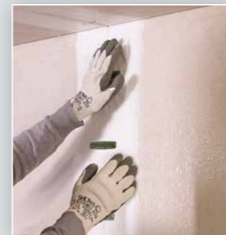
5. MB omnibind aanbrengen
