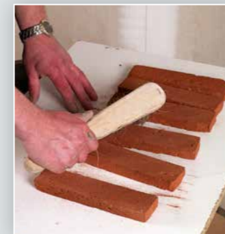
9. Stofvrij maken achterzijde Terca baksteenstrip
