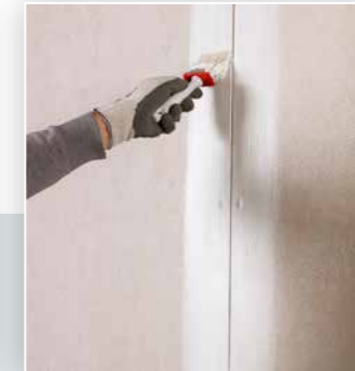
4. COAT omnibind aanbrengen bij overgang plaatnaad
