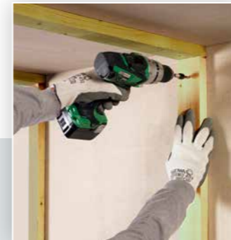
1. Aanbrengen draagstructuur
