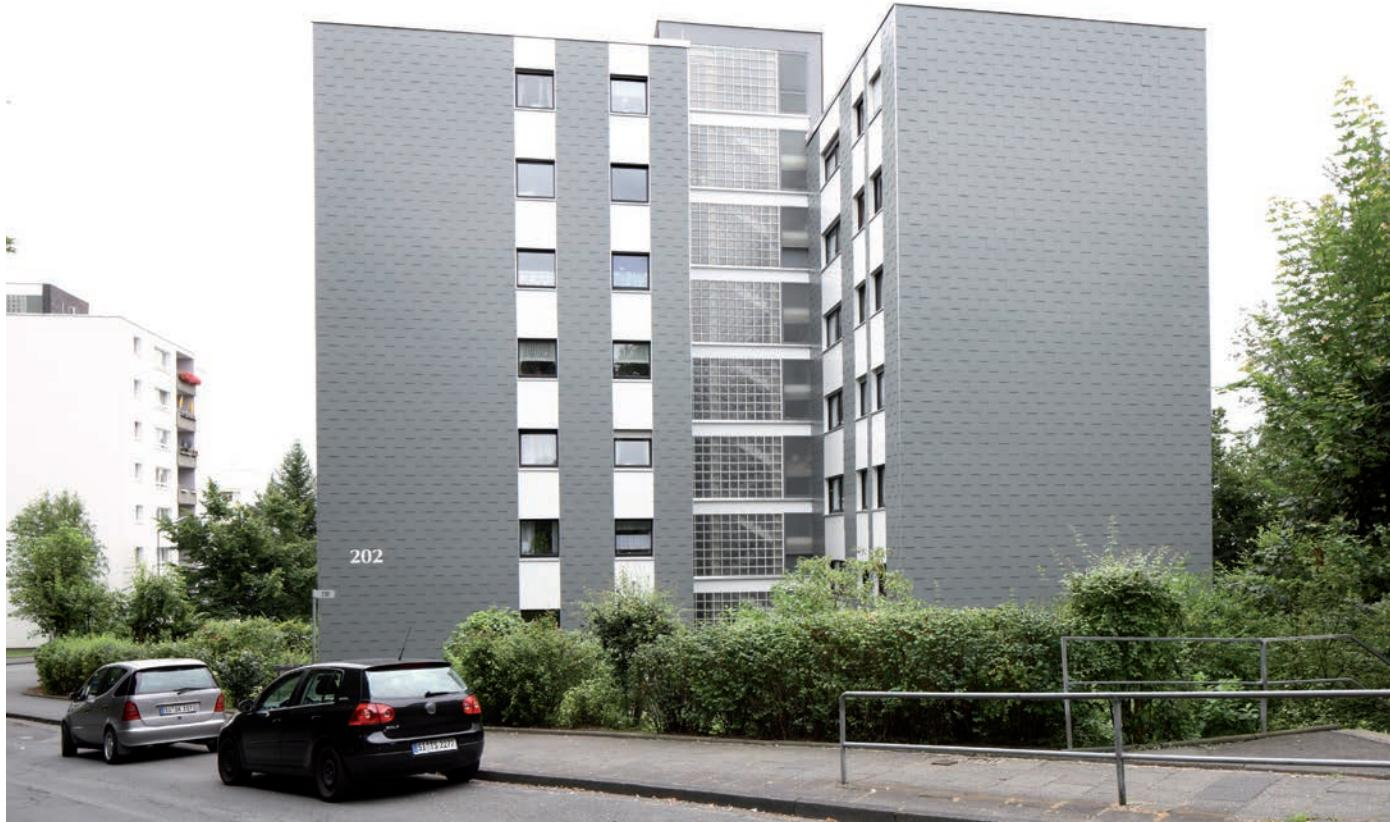
De gevel van de meergezinswoning in Siegen werd tijdens de renovatie nieuw bekled met zinkgrijze vezelcementleien die in dubbele dekking werden geplaatst en met plathaken werden bevestigd. Hierdoor kreeg de gevel een fraaie, buitengewone structurering. Het lichtgrijs zorgt samen met de witte gevelelementen onder de vensters voor een aangename aanblik.
