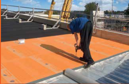
plat dak isolatie
