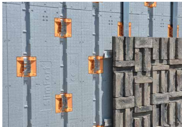
fischer draagsysteem met steenstripafwerking
