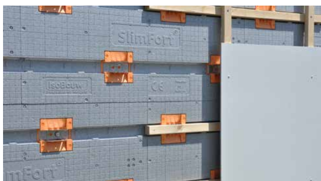
Afwerking met vezelcementplaten
